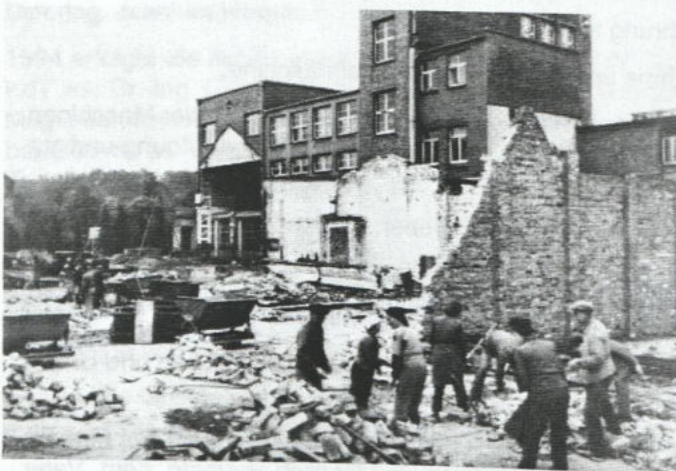
Aufbauarbeiten in der Fa. Pfauter Chemnitz (später: VEB Modul)
