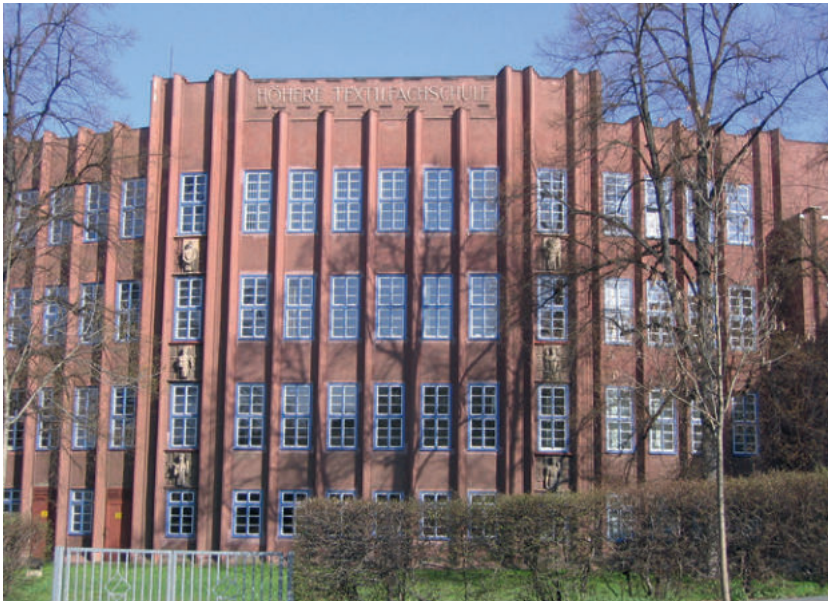
Gebäude des derzeitigen Studienstandortes in Reichenbach, 2023
