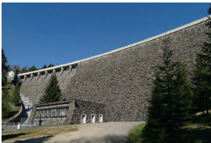
Die Staumauer der Talsperre Saidenbach beeindruckt durch ihre schiere Größe, ihre gewaltigen Bruchsteine bis zum Schieberhaus sowie die seitliche Hochwasserentlastung
