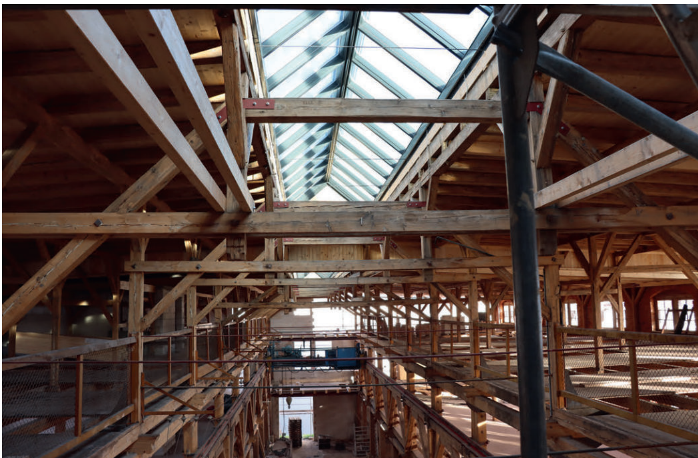
Holzhalle während der Sanierung, 2022
