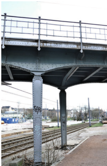
Die Ostbrücke an der Augustusburger Straße in Chemnitz
