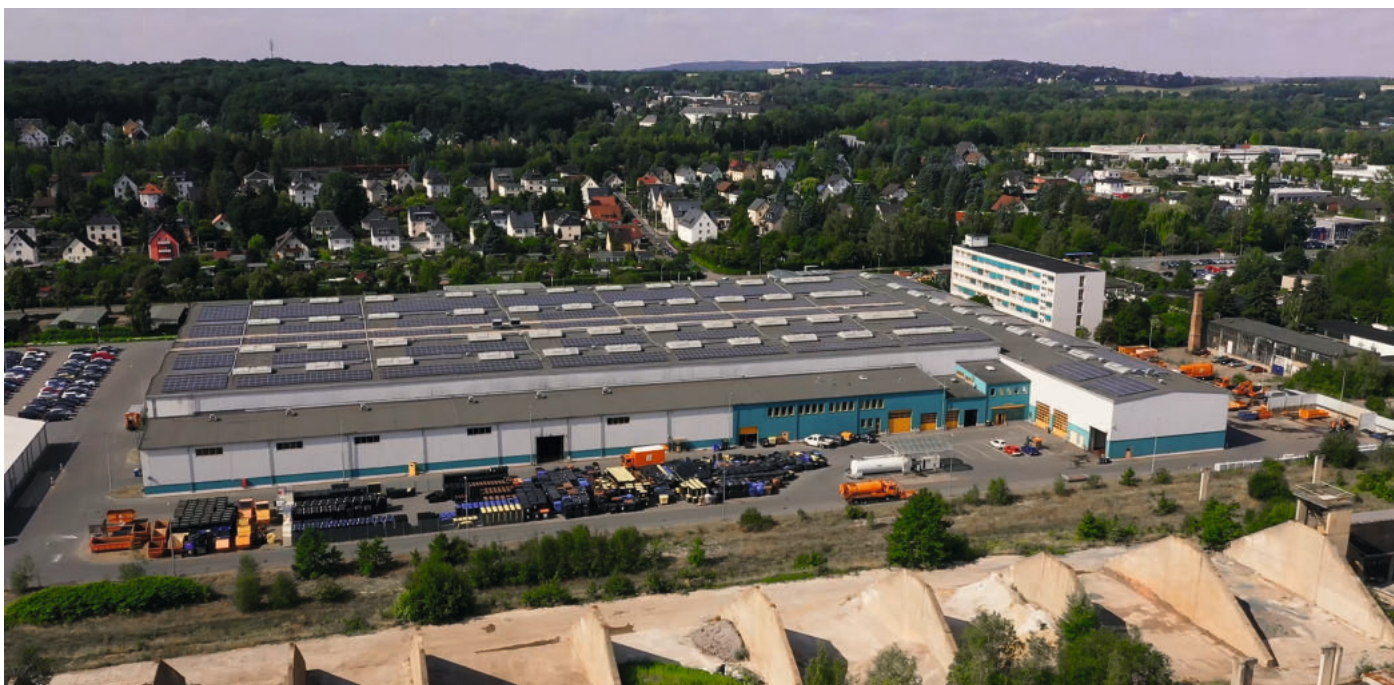
Luftaufnahme des Abfallentsorgungs- und Stadtreinigungsbetriebes der Stadt Chemnitz (ASR), Betriebshof Blankenburgstraße 62, 2021
