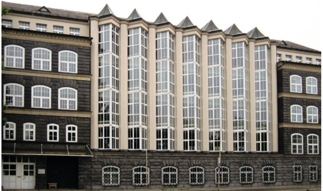
Gebäude der ehemaligen Mechanischen Wollwarenfabrik „Sachsen“ in Chemnitz-Kappel, Zwickauer Straße 173, 2015
