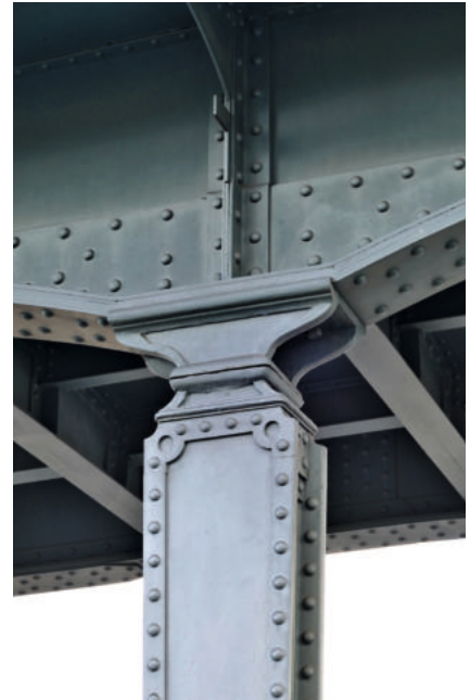
Detail einer Stütze der Ostbrücke
