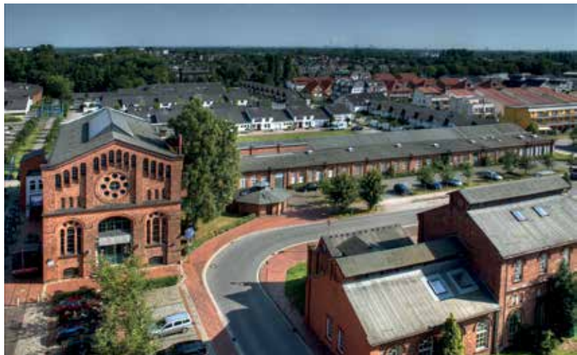
Turbinehalle mit Sheddach-Riegel. Dahinter neue Wohnhäuser auf dem Areal der abgerissenen Fabrikhalle, rechts noch erkennbar die Sheddächer.
