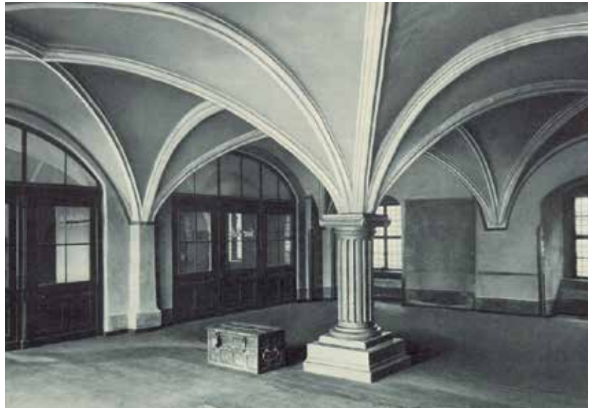
Turmstube des alten Rathauses Chemnitz
