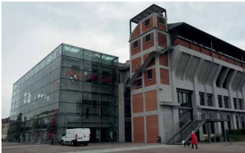
Nachts leuchtet der übergroße Fassadenschriftzug „La Fonderie“
