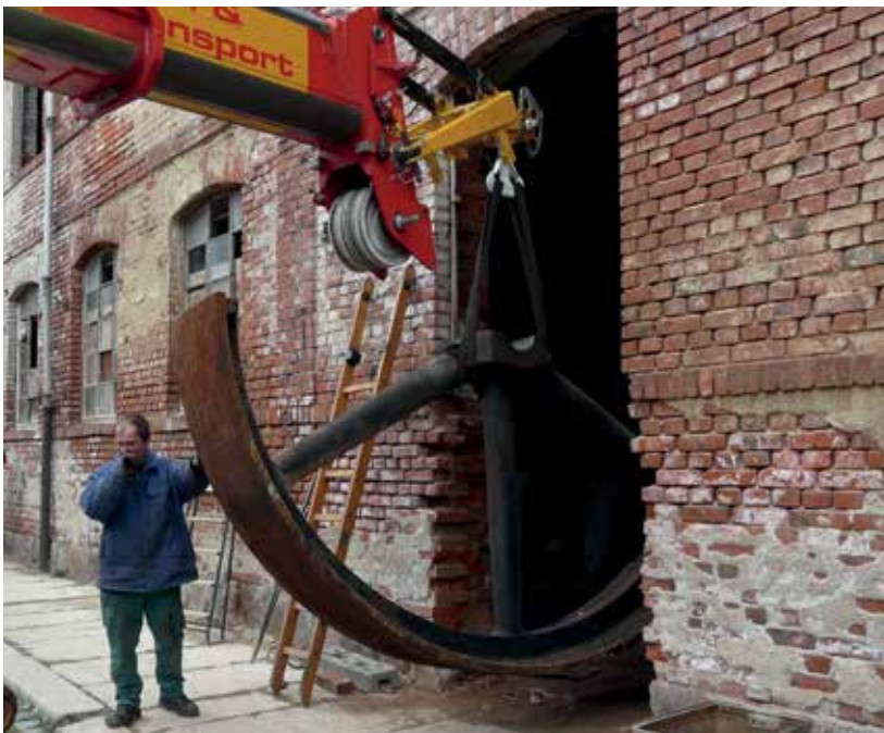
Demontage in der Peterstraße 5
