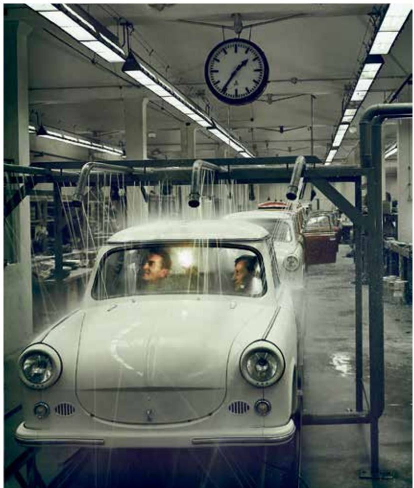
Trabant auf dem Dichtheitsprüfstand gegen Nässe, VEB Sachsenring Automobilwerke Zwickau, 1958
