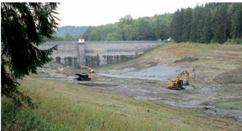
Sedimentberäumung im Staubecken
