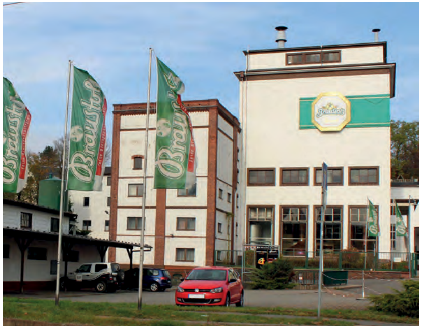
Gebäude der ehemaligen Braustolz-Brauerei, 2017
