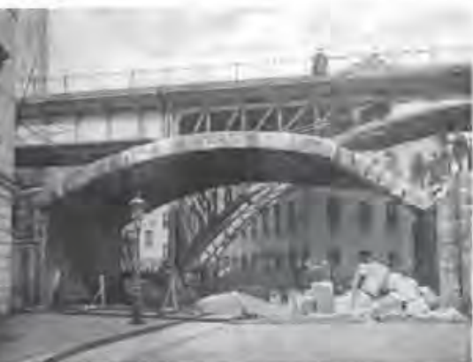
Abbruch des alten Viaduktes in der Beckerstraße, im Hintergrund das neuerbaute Viadukt
