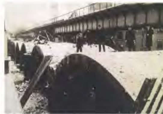
Abriss der Brücke 1909
