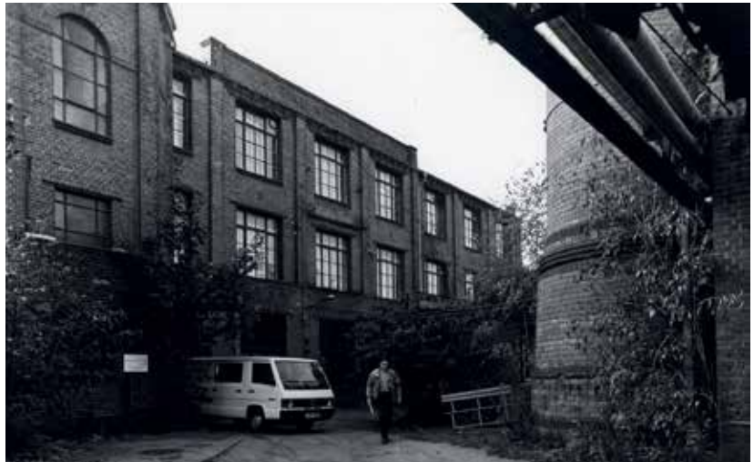
Fabrikhof der ehemaligen Teppichfabrik Bachmann & Ladewig, Zustand 1991.
