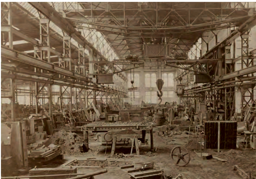
Die Halle der Großformerei in der Gießerei Seidel, Beschickung mit Kranen in zwei Ebenen.
