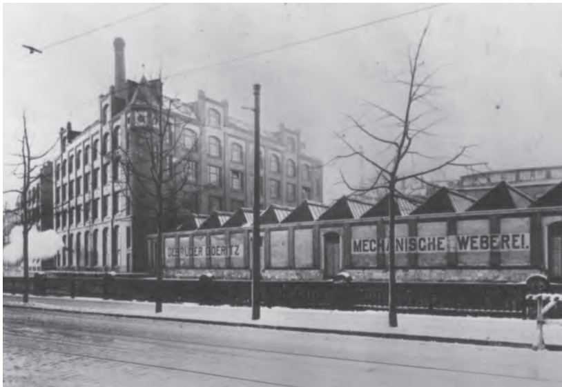
Fabrikgebäude der Gebrüder Goeritz AG von der Annaberger Straße aus gesehen.
