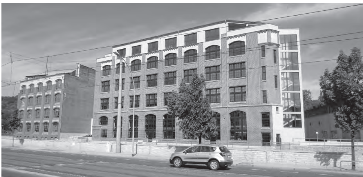
Das einstige Gebäude der Goeritz-Fabrik, 2015
