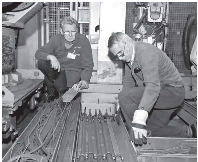
Lothar Grimm und Jochen Schmidt bei der Demontage der Schweißanlage im VW-Werk Mosel
