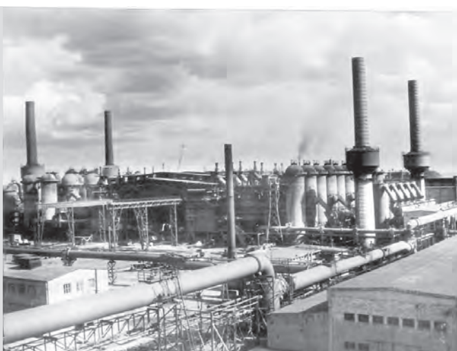
VEB Niederschachtofenwerk Calbe/Saale, Ofenhalle um 1955. Die Öfen sind in zwei Reihen zu je fünf Öfen an der Hallenlängsseite angeordnet und selbst nicht sichtbar; ihr Standort ist mit jeweils zwei Fackeln markiert, von denen rechts der Bildmitte zwei geöffnet sind und Rauch aufsteigt.
