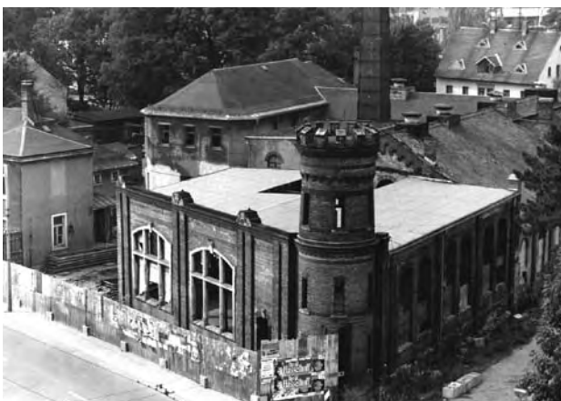
Baustelle Industriemuseum Chemnitz an der Annaberger Straße, um 1990
