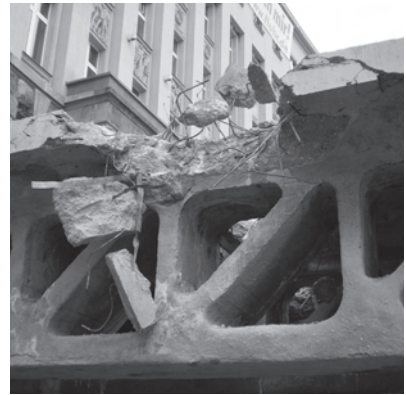
Brückenträger während des Abbruchs, 2009
