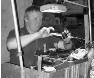
Glasfasermontage unter dem Montagezelt
