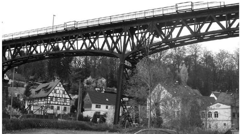
Rabensteiner Viadukt im November 2008
