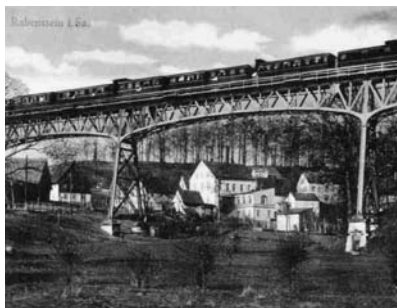
Das Viadukt auf einer alten Postkarte
