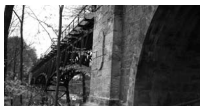
Seitenansicht des Viadukts
