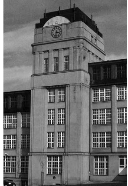
Turm der Wanderer-Werke AG, Chemnitz
