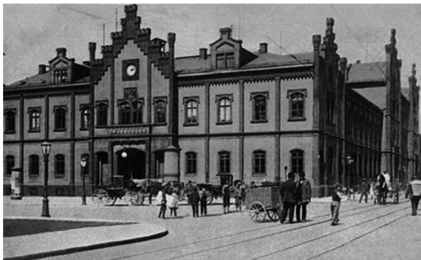
Chemnitzer Hauptpost, 1859 erbaut
