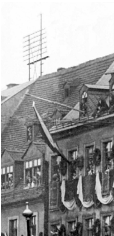
Dachgestänge am Markt in Chemnitz, 1899
