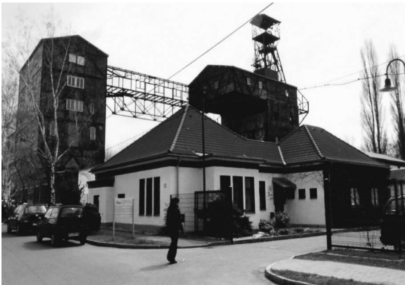
Ansicht West des Förderturmes mit Schachthaus, Verbindungsbrücke und Trockensortierung von der Friederikenstraße aus.
