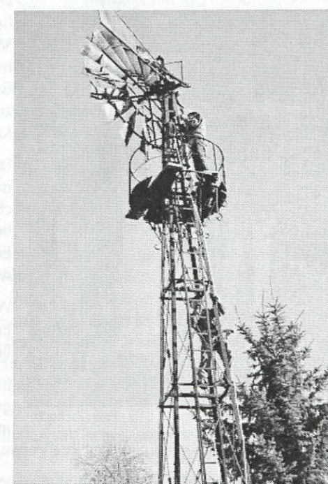
Tim Lücke beim Abbau des Windrades Foto: Kunze
